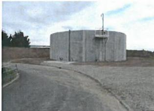
Cuve béton pour le stockage liquide / semi-liquide et solide
