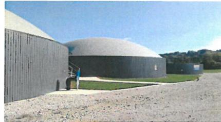
Vue d'ensemble : digesteur, post digesteur, stockage digestat brut
