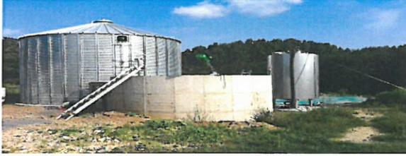
Vue d'ensemble : digesteur (G), cuve intrants solides (milieu), cuve intrants liquides (D)
